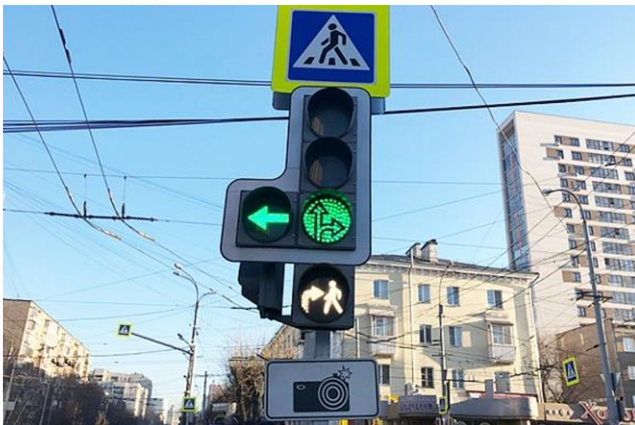
Рисунок 3.3.5 – Пример применения информационной световой секции бело-лунного цвета с изображением пешехода (по ГОСТ Р 52289-2019)
